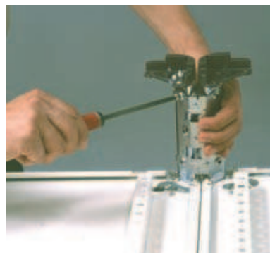
Combinaties van wandverdelers en kokers van 300 mm kunnen makkelijk en snel tot stand worden gebracht met behulp van vastschroefbare metalen koppelstukken.
